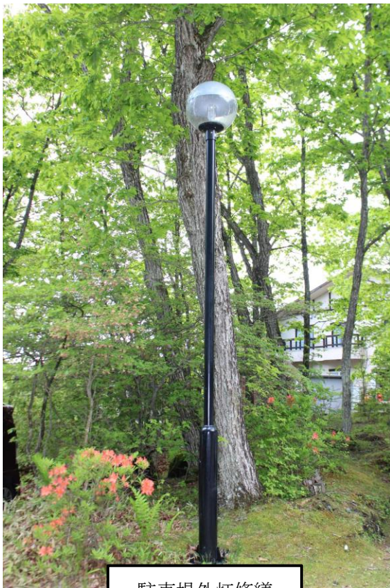
駐車場外灯修繕
