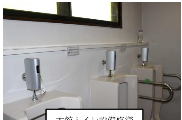
本館トイレ設備修繕
