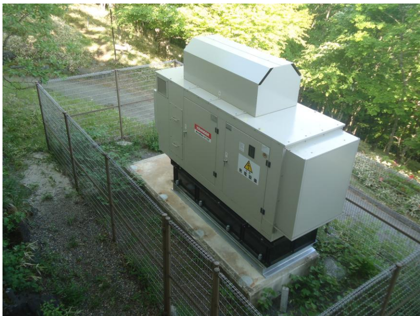
【非常用発電機更新】
