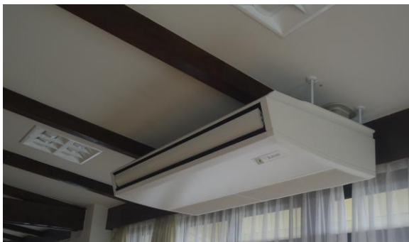
大食堂エアコン取付
