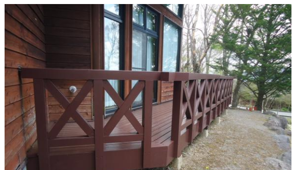
天狗岳ベランダ修繕
