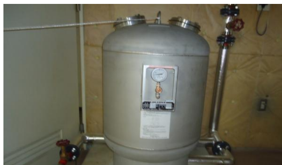
機械室膨張タンク更新
