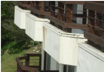
【建物診断調査写真(例)】
